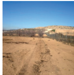
9.- Preparación del terreno
