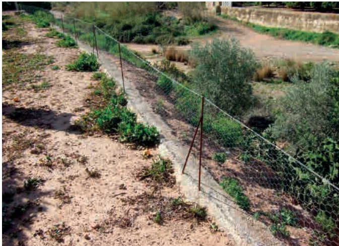
Vallado reforzado con colada de hormigón.
